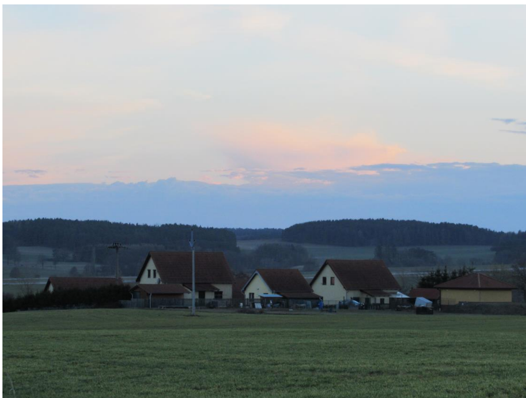
4 povodňové domky čp. 18, 21, 38, 50 a vodárna postavené po povodni 2002
