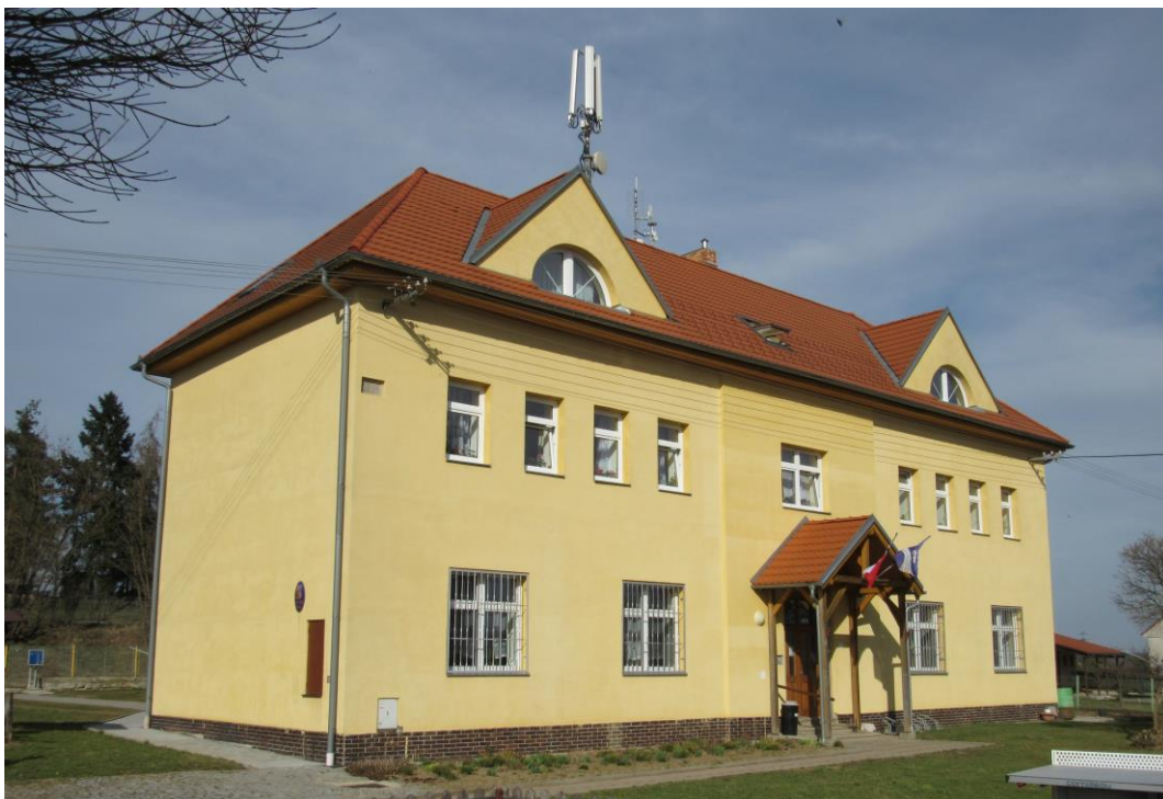
Budova obecního úřadu čp. 77 s 8 byty
