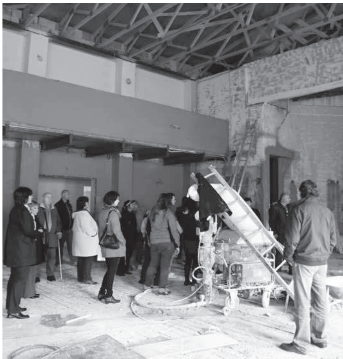
Komunitní centrum, velký sál, foto říjen 2013
