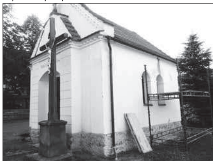
Kaple P.M. při rekonstrukci
