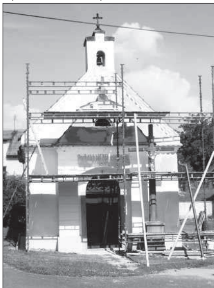
Kaple P.M. při opravě
