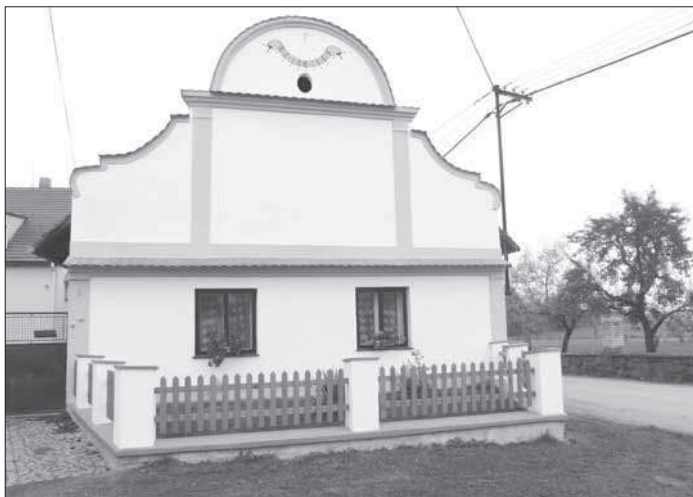
Opravený štít zemědělské usedlosti č.p. 1 v Buzicích s volutami a slunečními hodinami
