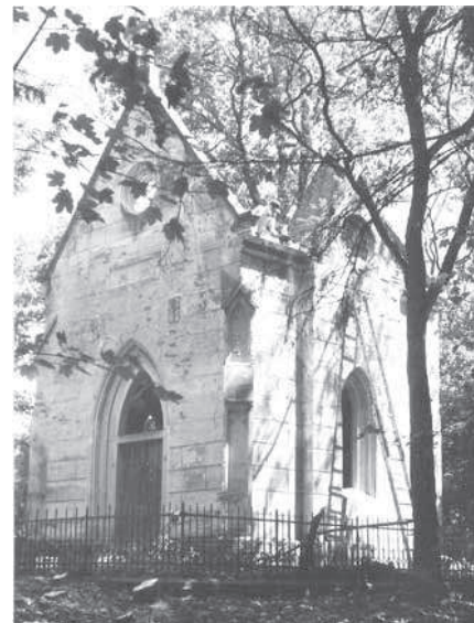
Stav kaple v průběhu prvních záchranných prací, květen 1999
