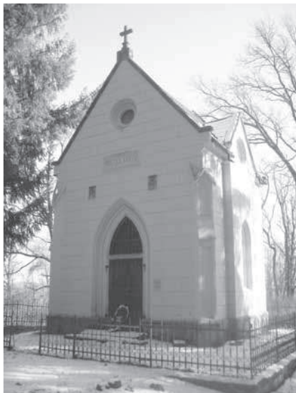
Stav kaple po rekonstrukci, únor 2011 (foto autor příspěvku)
