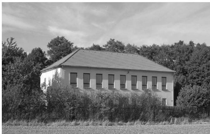
Velká Turná - škola s opravenou střechou
