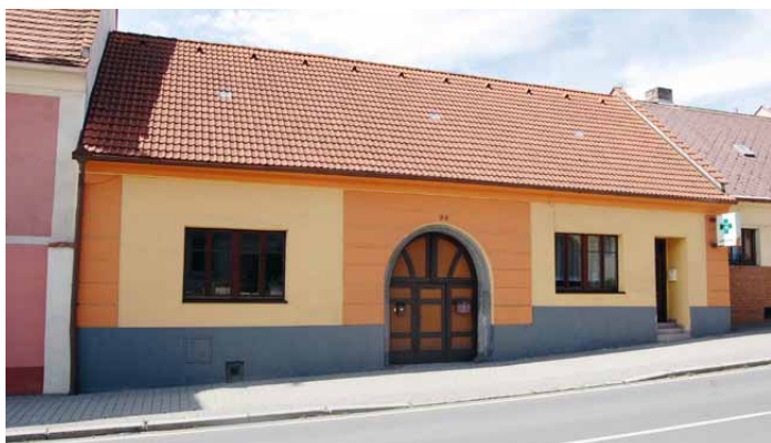
Dům čp. 99 v červenci 2017 (foto autor příspěvku)
