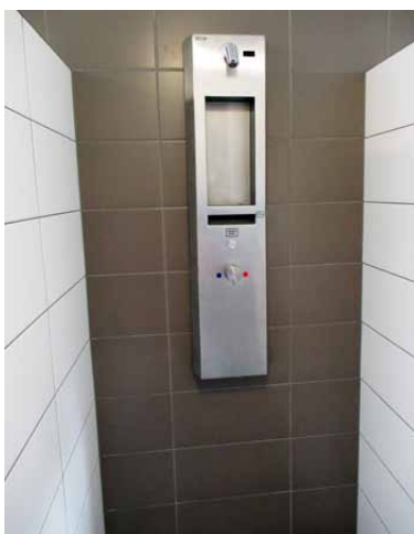
Nově zrekonstruované sprchy ATC-Milavy
