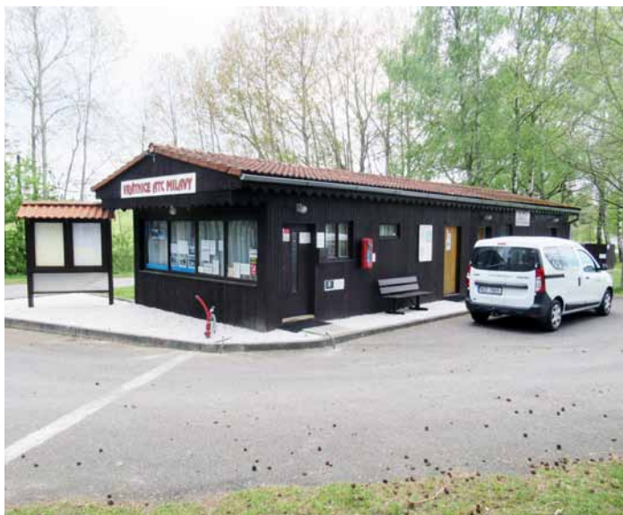
Budova sociálního zázemí s vstřanicí ATC-Milavy
