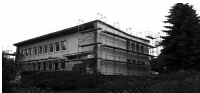
Práce na MŠ probíhaly velmi dobře a se zhotovitelem jsme byli spokojeni
