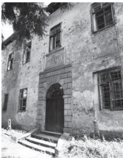
Vstupní portál zámek
