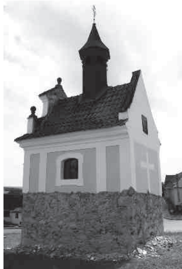
Oprava kaple dne 12.7.2014
