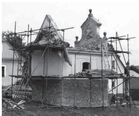
Oprava kaple dne 2.9.2014
