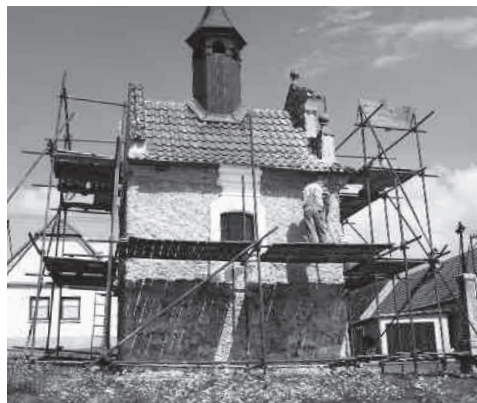
Oprava kaple dne 29.7.2014
