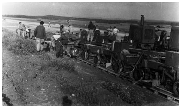
Finišer na položení a urovnání betonu v roce 1961 (z archivu Františka Křivance)
