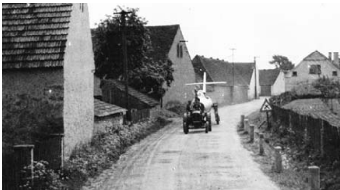
Přeprava letadla MiG-15 traktorem ze Tchořovic směrem na Hradiště v těsné blízkosti domu čp. 32 (archiv obce)
