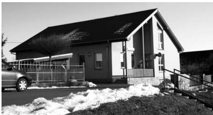
Opravená střecha pohostinství
